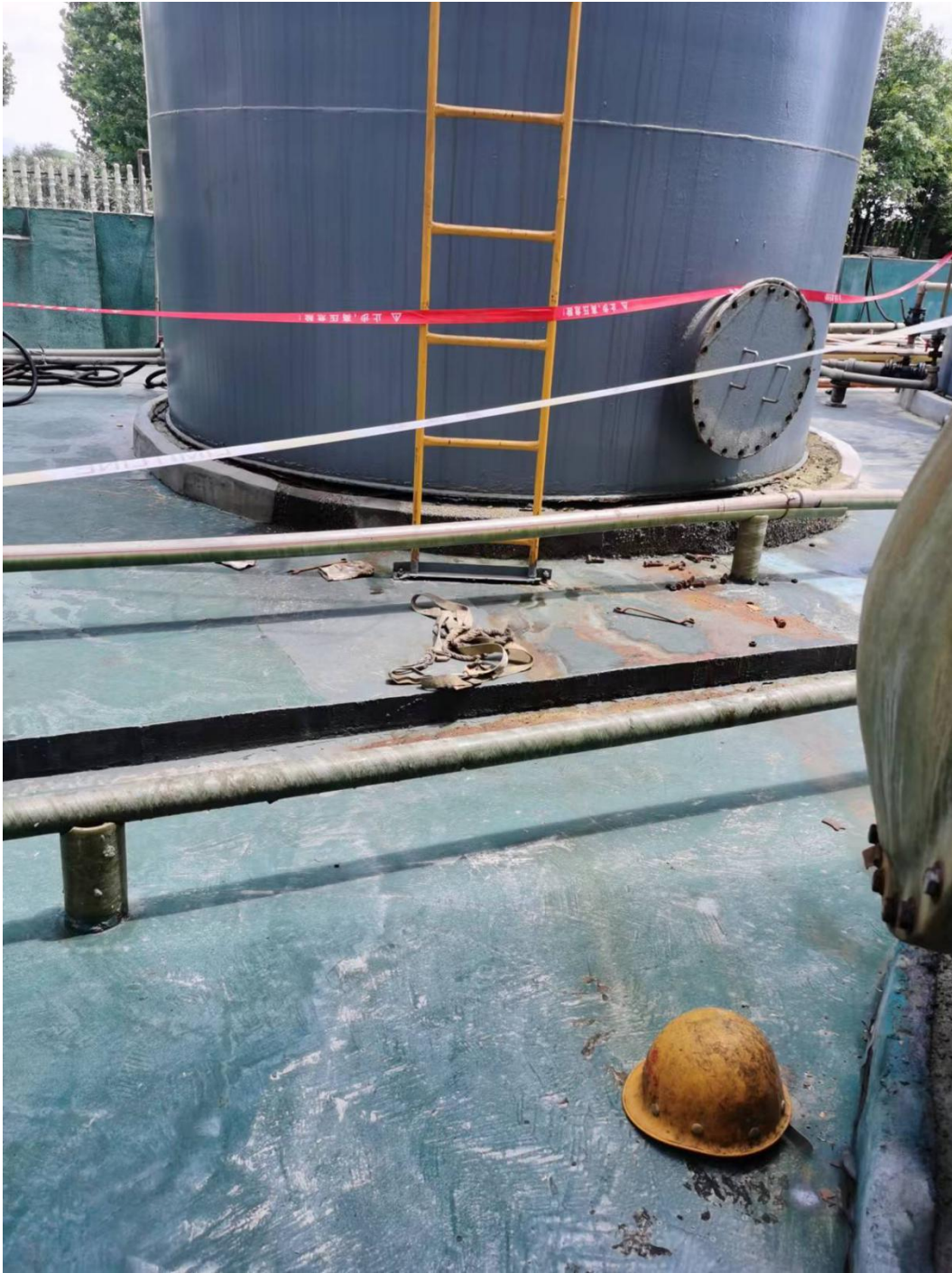
附图二 24号储罐地面散落的工具
