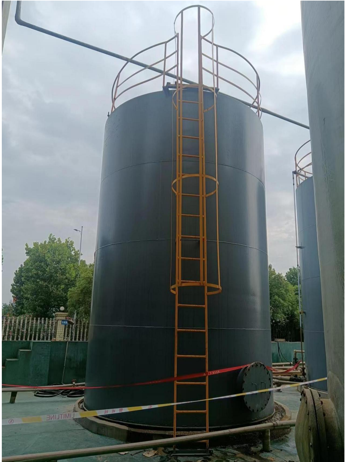
附图一 建衡实业新聚氯化铝车间盐酸储罐区 24 号储罐
