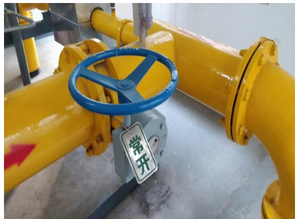
调压器前端进口阀门
