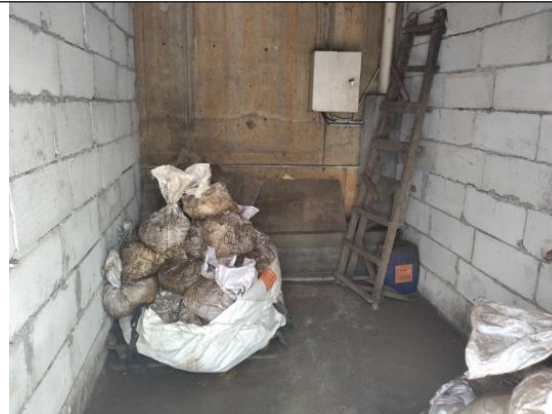
危险废物暂存间
