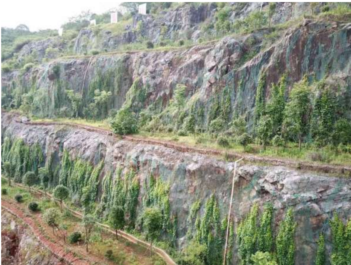
图 4-3 同类矿山台阶复绿效果（施工一年效果）
