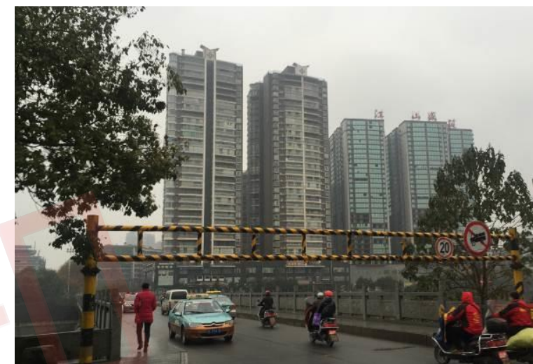
7-14 青草桥桥头建筑过高
