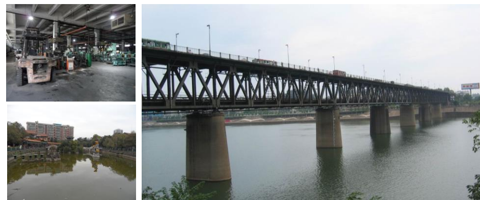
2-11 原建湘柴油机厂和湘江上的公铁大桥
