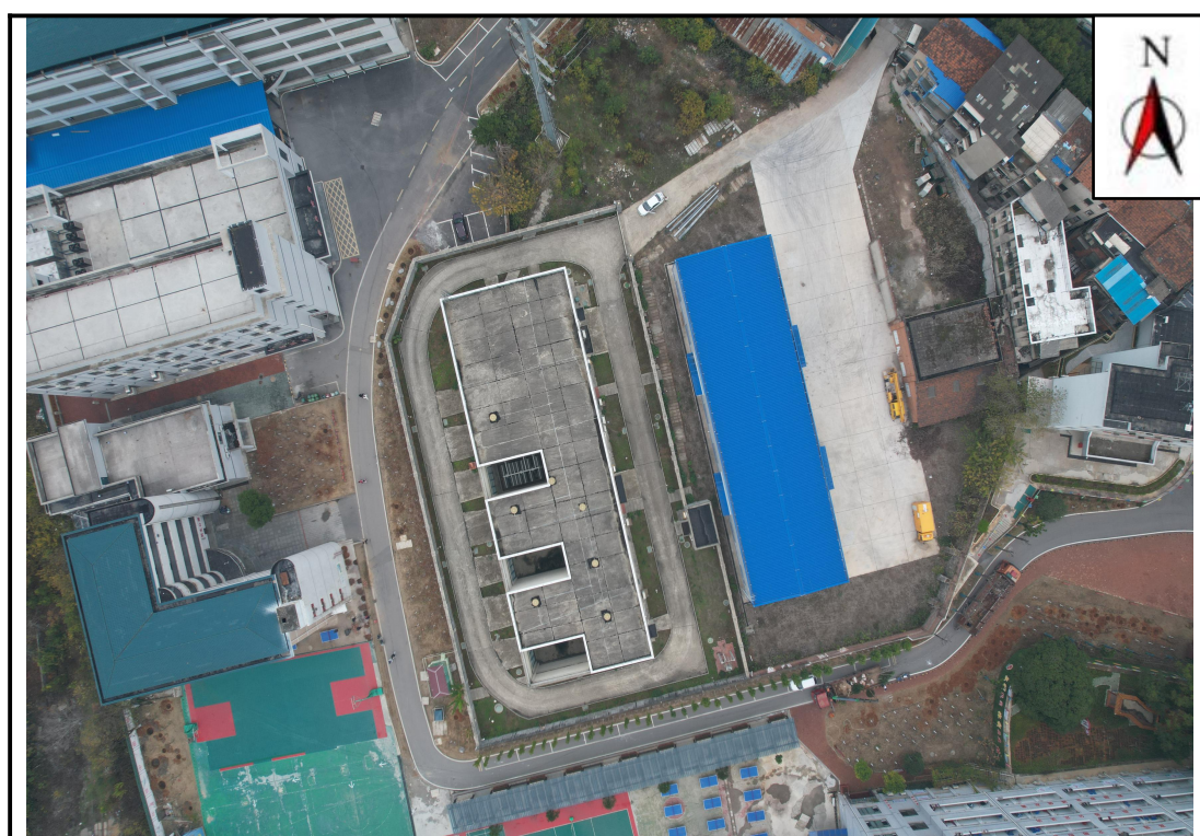
图 3-2 和平 110kV 变电站周围环境现状
