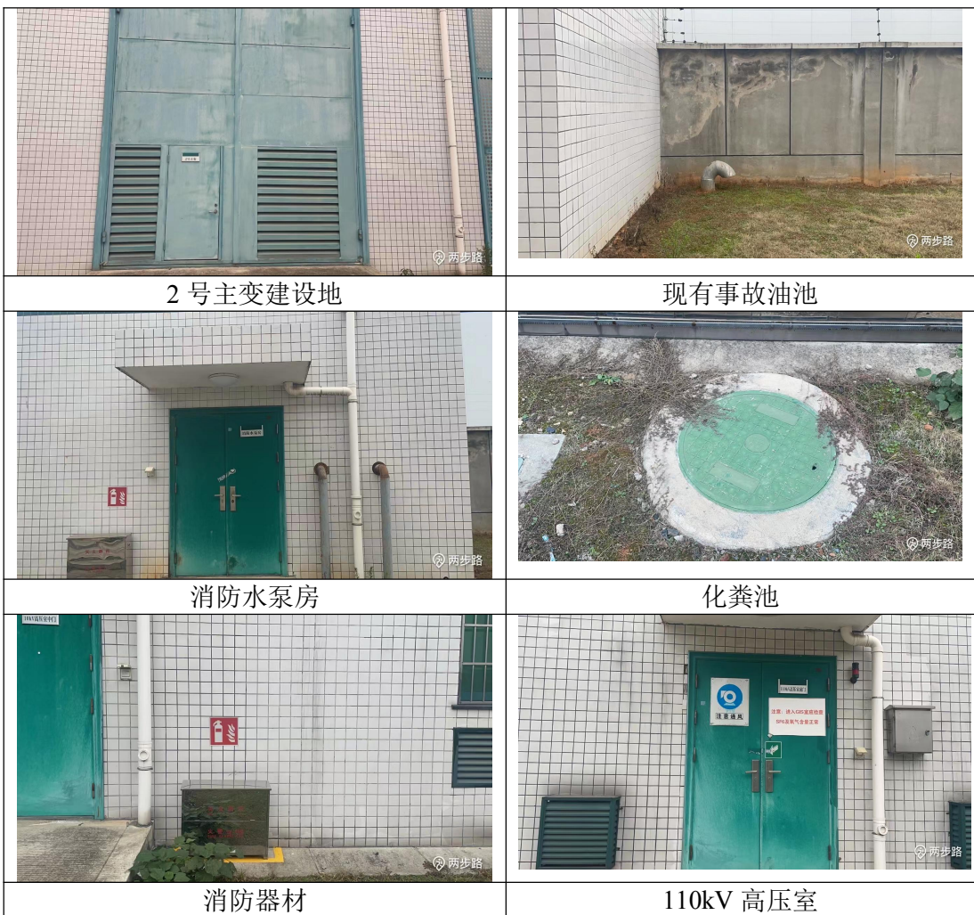
图 2-1 变电站站内环境现状
