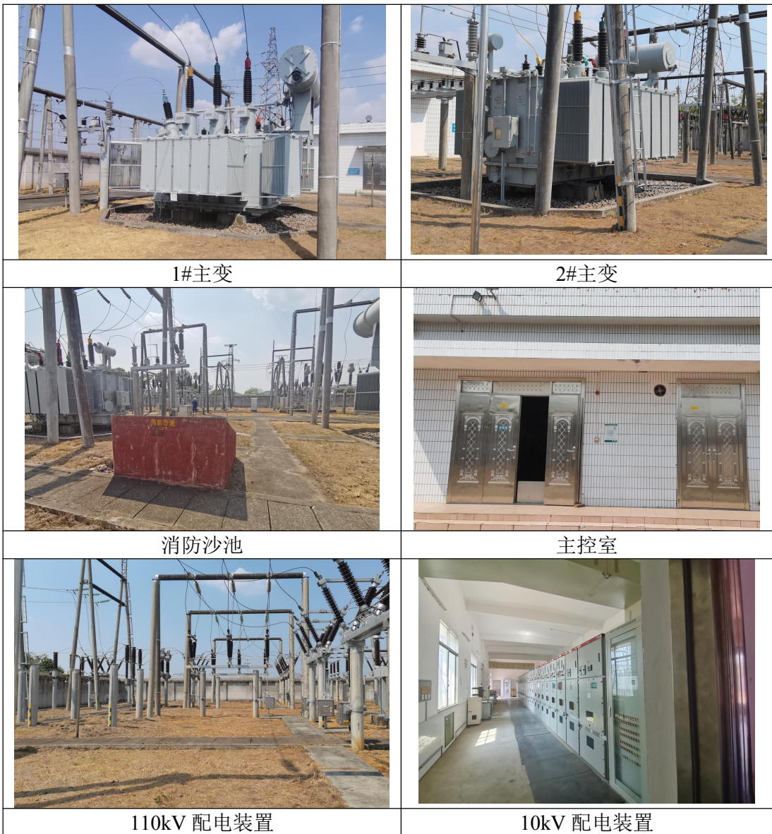
图 2-1 变电站站内环境现状
