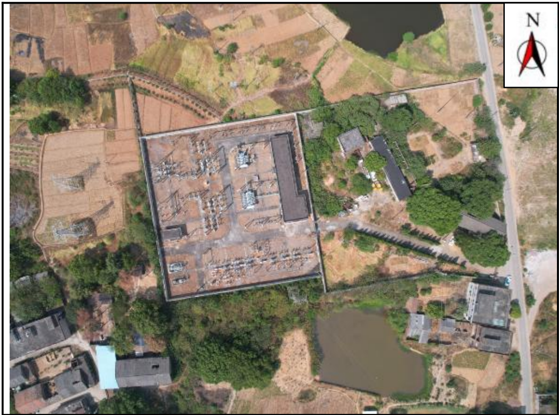
图 3-2 衡阳耒阳遥田 110kV 变电站周围环境现状
